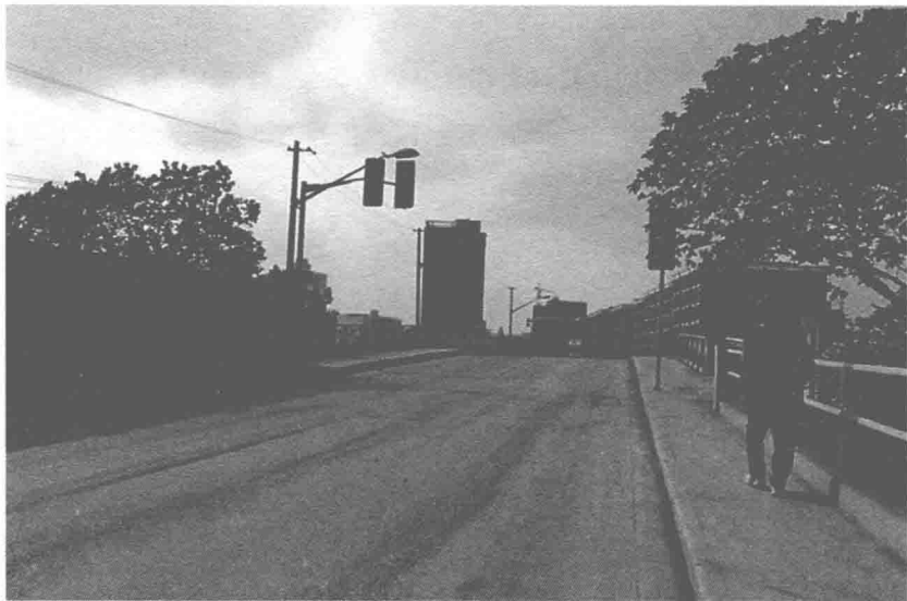
复兴岛北端的 海安路桥
